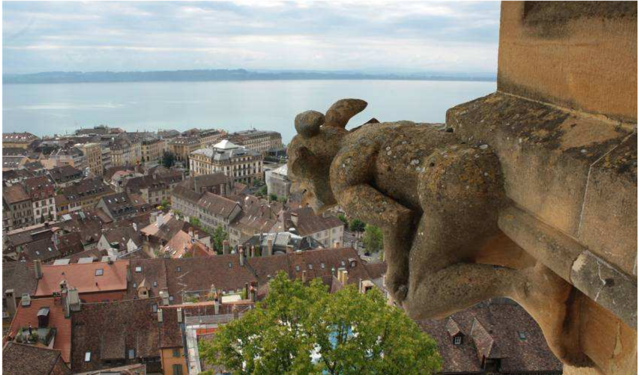
Vue du Sud-Est de la ville depuis la tour du chevet sud
